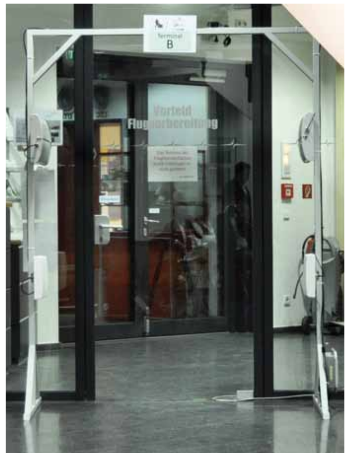
RFID Torrkonstruktion während der Testphase im Terminalgebäude des Flughafen Schönhagen
