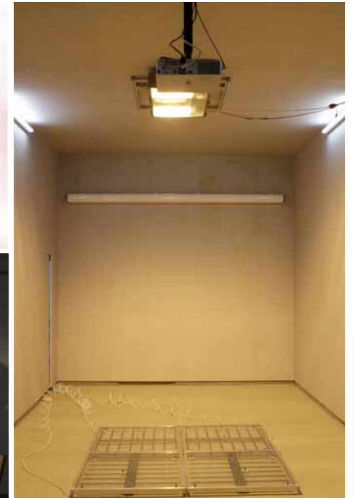
Abb. 36: Testlabor mit Tunnelleuchte und Beleuchtungsstärkemessfeld
